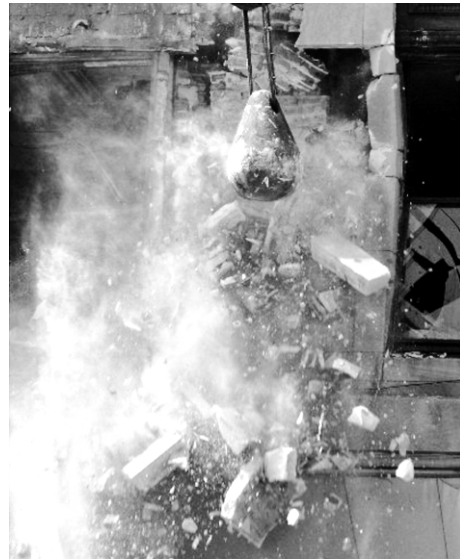
slopen met een sloopkogel
